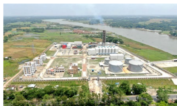
通用技术中机公司孟加拉莫图莫迪重油项目创建绿色厂区，对厂区生产生活污水进行实时监测，确保污水达标排放
