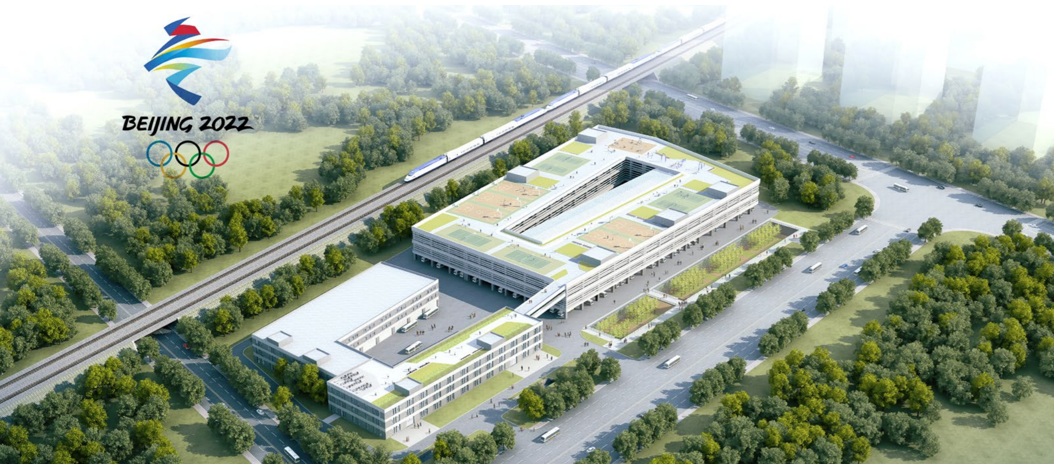
通用技术新兴公司所属新兴建设承建北京冬奥会延庆综合交通服务中心工程
